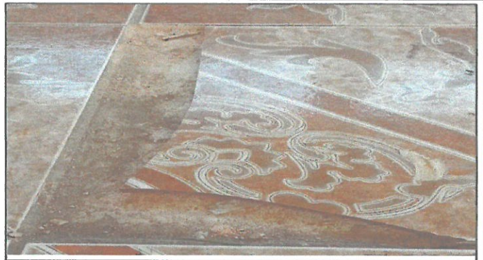
Foto 2: sustitucion de piso del segundo nivel.
