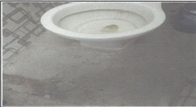
Foto 9: mejoramiento de sanitario, instalacion de piso asulejo de granito.
