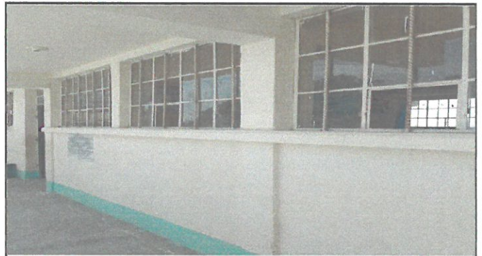
Foto 4: istalación de balcón segundo nivel.
