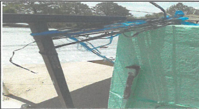
Foto 7: sustitucion de baranda 1
