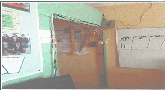
Foto 11: sustitucion de pared prefabricado 1
