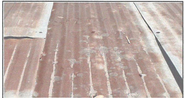
Foto 10: sustitucion de techo sanitario
