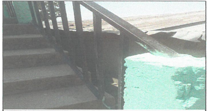
Foto 8: sustitucion de baranda 2
