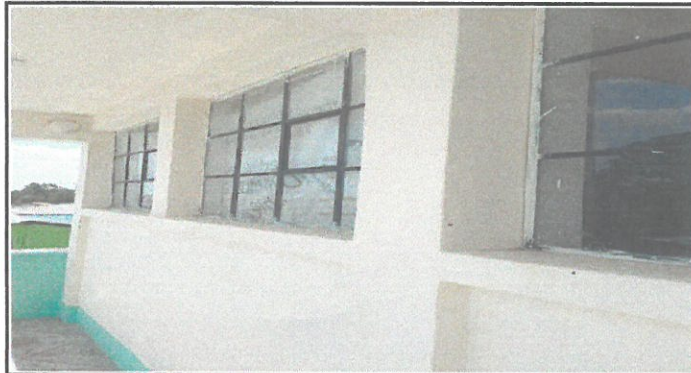
Foto 3: istalación de balcón primer nivel.
