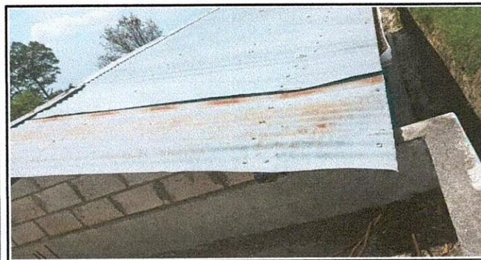
Foto 11: Sustitución de láminas del techo de la bodega.
