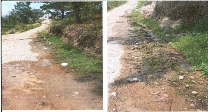
Foto 7: Sustitución de fosa séptica
