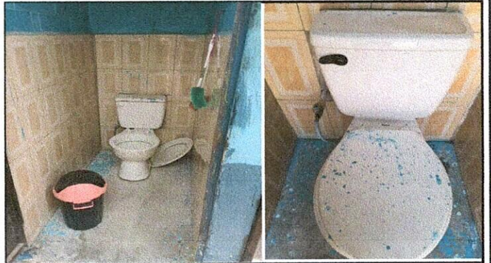
Foto 4: Sustitución de baños sanitarios, sustitución de tubería de drenaje de baños.
