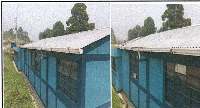
Foto 9: Sustitución de ventanas e instalación de balcones
