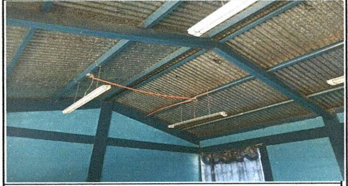
Foto 2: Sustitución de: plafoneras, focos, apagadores, tomacorrientes y canaletas de electricidad.
