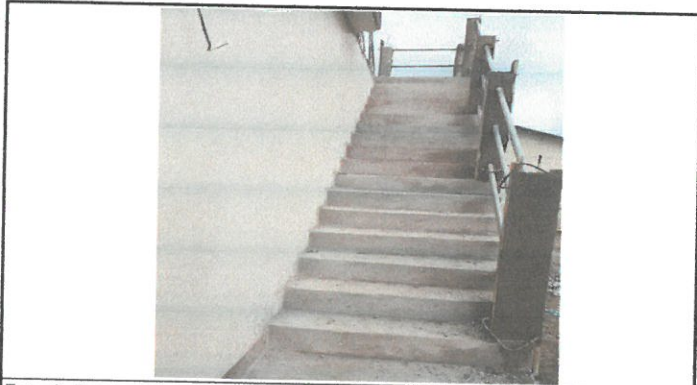
Foto 3: Reparación de gradas de madea a concreto. Finalizado.
