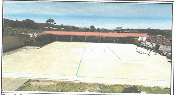
Foto 2: Pavimentación de cancha deportiva. Finalizado.
