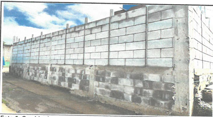
Foto 5: Cambio de muro de contención. Finalizado.
