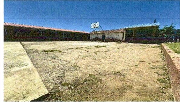
Foto 2: Reparación de pavimento de la cancha deportiva
