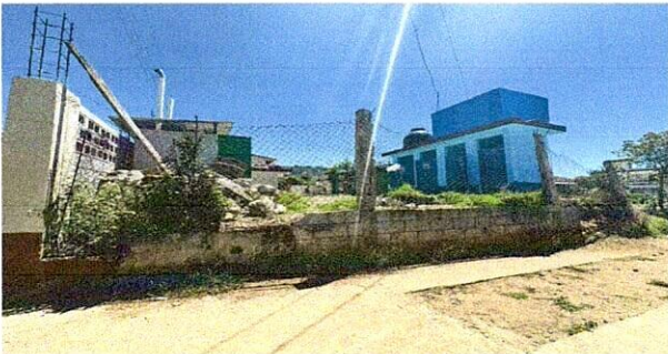
Foto 5: Cambio de muro de contencion.
