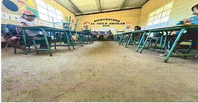
Foto1: Reparación del piso rustico a piso de granito
