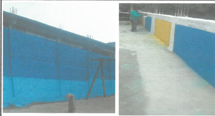
Foto 1: Remozamiento muro de contención
