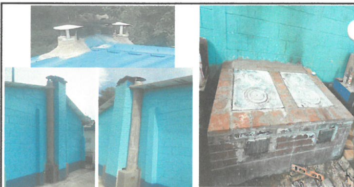
Foto 4: COCINA: Sustitución de chimenea y reparación de pollo de dos planchas
