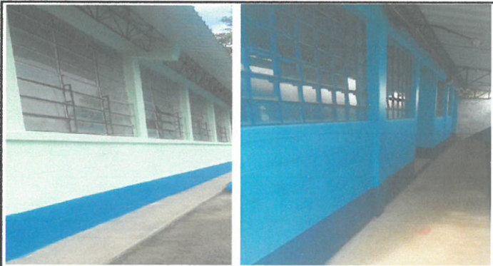
Foto 2. pintura de muros exterior
