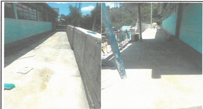
Foto 3.1: Pavimento cercano al muro de contención módulo 1
