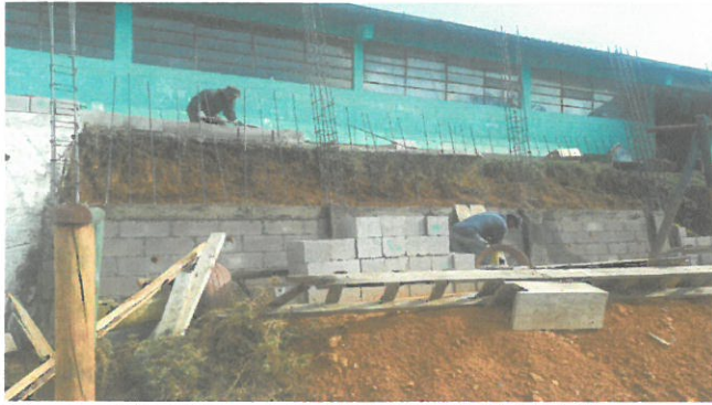
Foto 1: Remozamiento muro de contención
