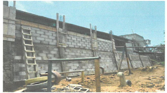
Foto 1.1 Remozamiento muro de contención.
