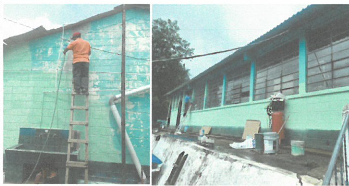
Foto 2. pintura de muros exterior
