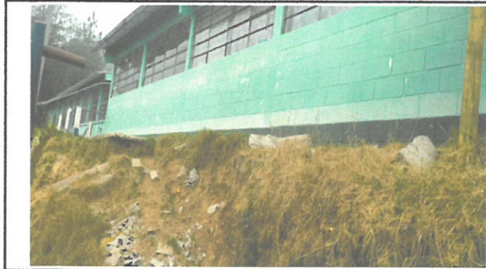
Foto 1: Remozamiento muro de contención
