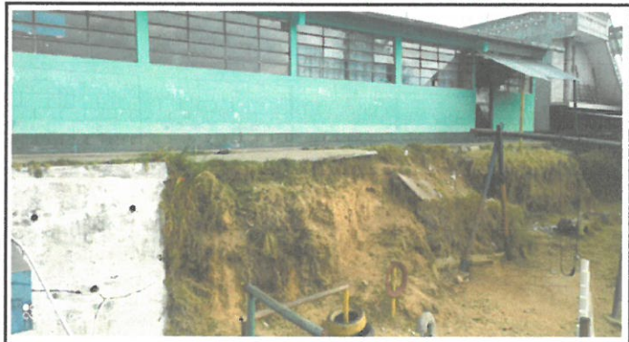
Foto 1.1 Remozamiento muro de contención.
