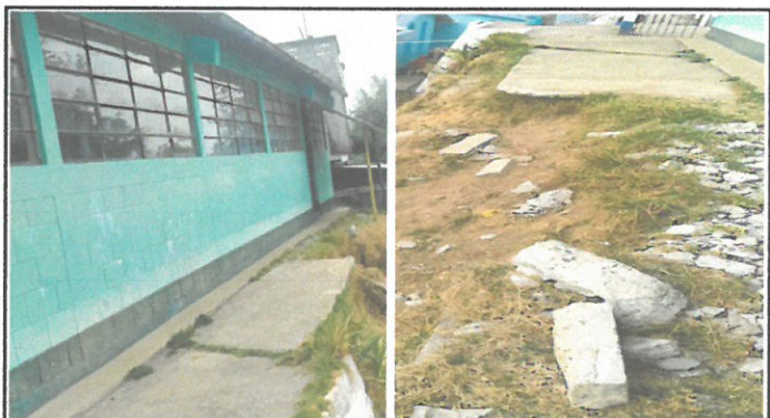
Foto 3.1: Pavimento cercano al muro de contención módulo 1
