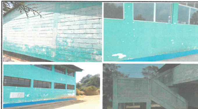
Foto 2: pintura de muros exterior
