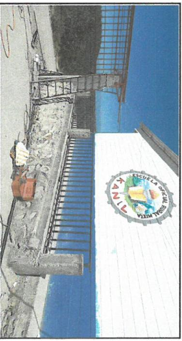
Foto 4: Vista de barandas de tubos de metal instaladas en la entrada del establecimiento
