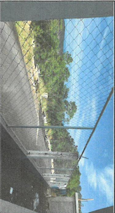
Foto 1: Vista de la malla galvanizada que se colocó en la parte frontal del establecimiento
