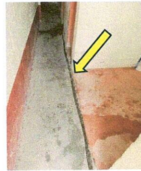
Foto 4: Sustitucion de piso rustico por ceramica antideslizante.
