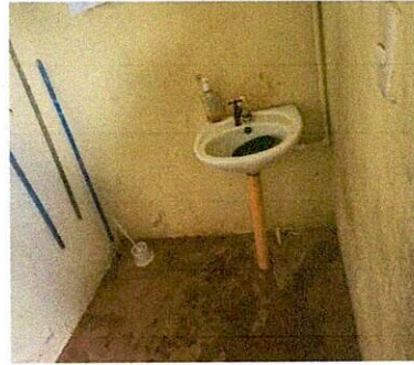
foto 2: Sustitucion de lava manos de losa
