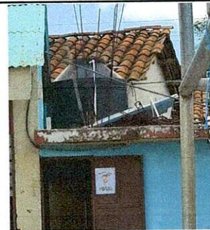
Foto 6: Sustitucion de sistema de 1,000 litros por sistema de 2,500 litros.
