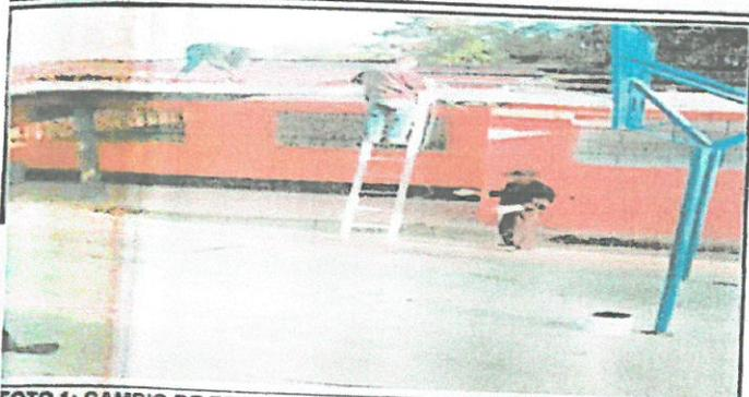
FOTO 1: CAMBIO DE TECHOCOMPLETO EN PROCESO DEL MODULO
