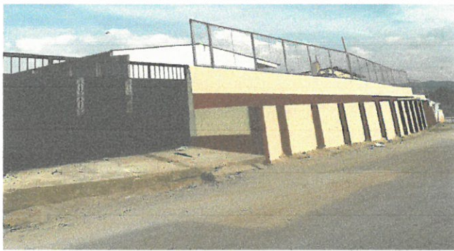
Vista de malla que circula el establecimiento finalizado.
