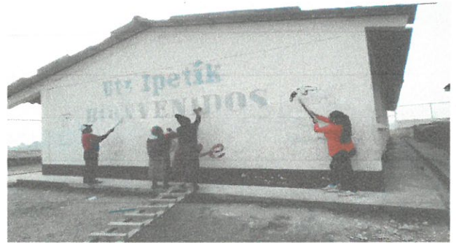
Vista de pintura del establecimiento en proceso a remozar.
