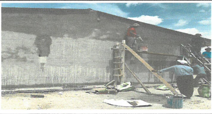
Vista de pintura del establecimiento en proceso a remozar.
