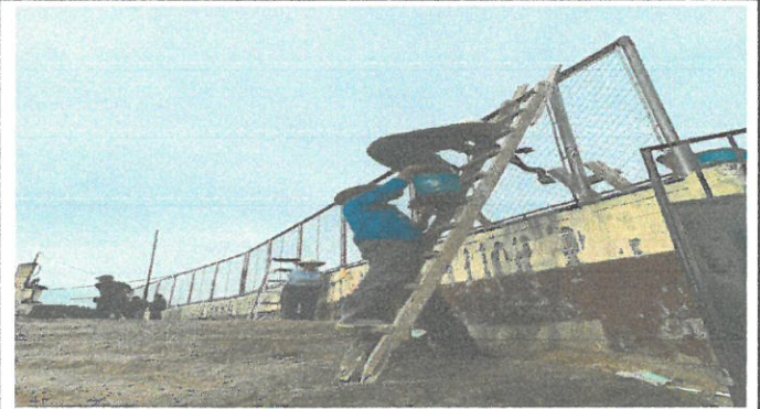
Vista de malla que circula el establecimiento en proceso a remozar.
