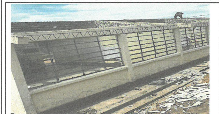
Vista del segundo modulo del establecimiento en proceso a remozar.
