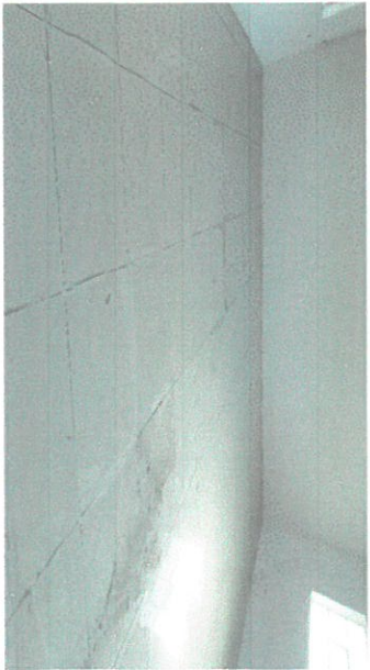
Foto 1: culminación de colocación de pisos
