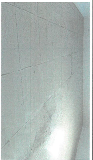
Foto 2: Instalación de piso en 7 aulas
