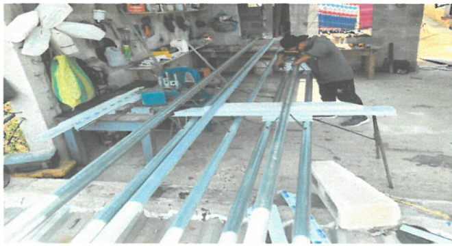
Foto 3: Vista del acople de los tubos para formar las columnas para el soporte del techo
