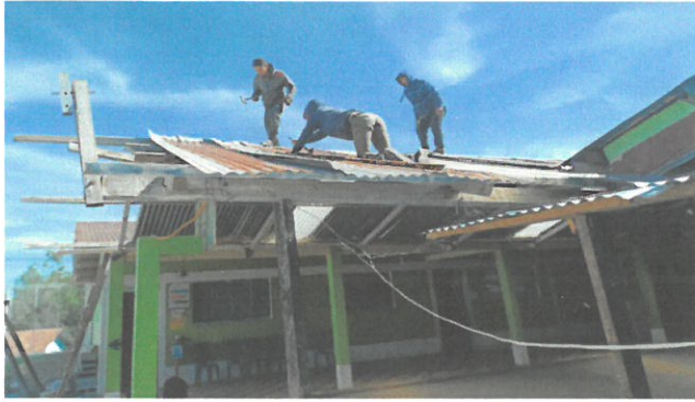
Foto1: Vista de la desmantelación de las láminas.
