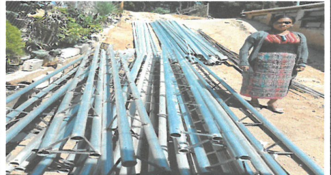
Foto 4: Vista de las columnas listas para ser colocadas en el concreto.
