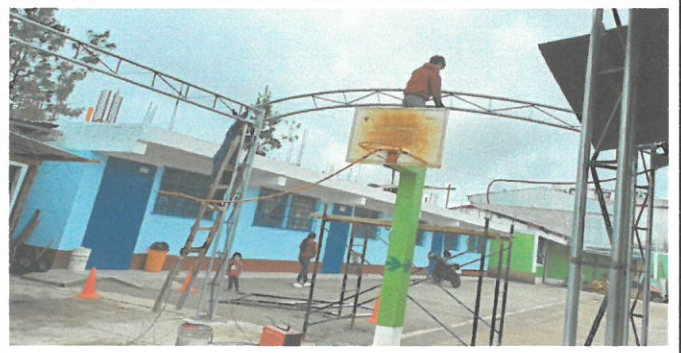
Foto 6: Vista del ensamble de las vigas de metal con las columnas.
