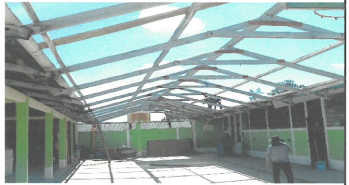
Foto 2: Vista del derribe de las vigas.
