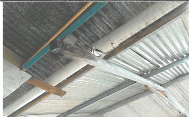
Foto 2: Vista de vigas que serán sustituidas.
