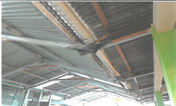
Foto 3: Vista de techo para reparar.
