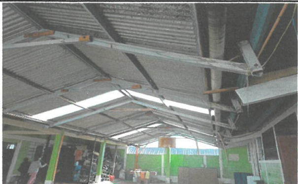
Foto1: Vista de techo a Remozar.
