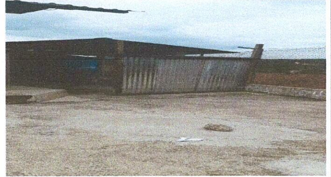
Foto 2: Cambio de lámina acanalada por lámina troquelada
