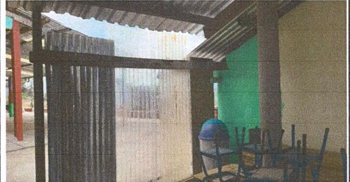
Foto 2: Paredes de lámina cambio por paredes de blok
