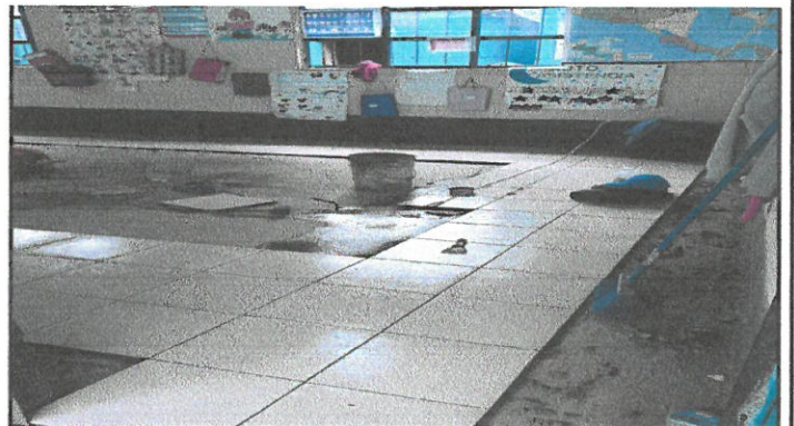
Foto 4: Mejoramiento de aulas con pisos ceramicos
