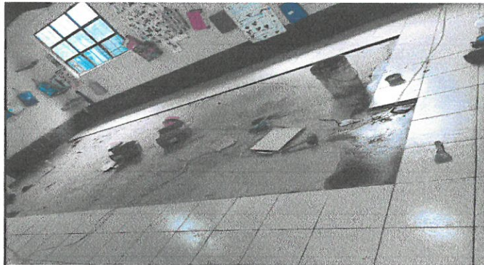
Foto 3: colocación de pisos
