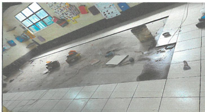
Foto 3: colocación de pisos
