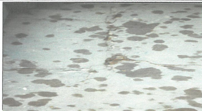
FOTO 1: Cementado de aula en mal estado
