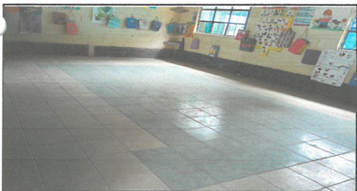
FOTO 5: Aula con piso ceramica culminado
