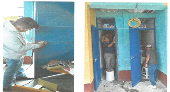
Vista de puertas en proceso de remozamiento.
