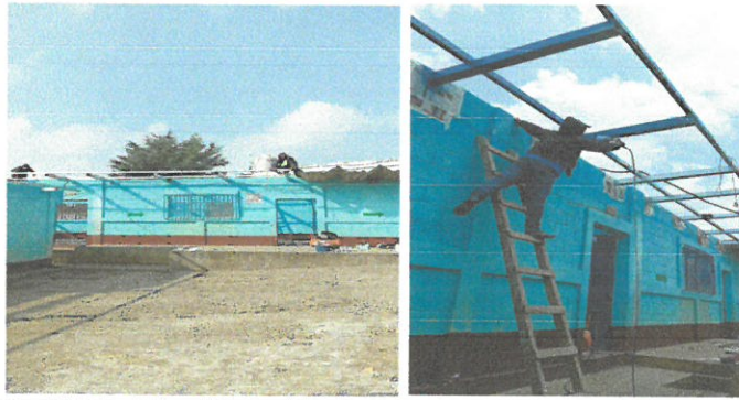
Vista de techo en proceso de remozamiento.
