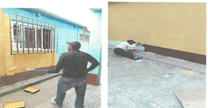
Vista de paredes en proceso de ser pintadas a remozar.
