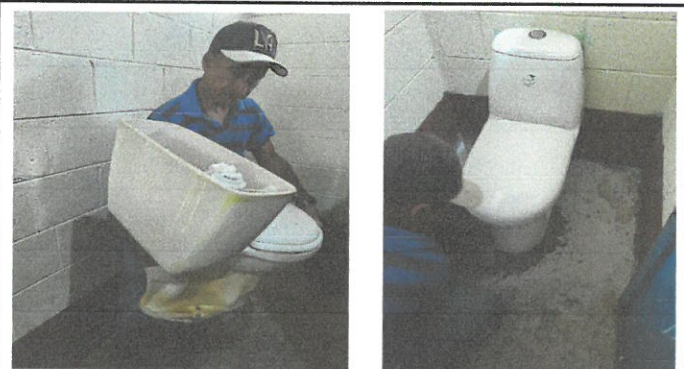
Vista de baños sanitarios en proceso de remozamiento
