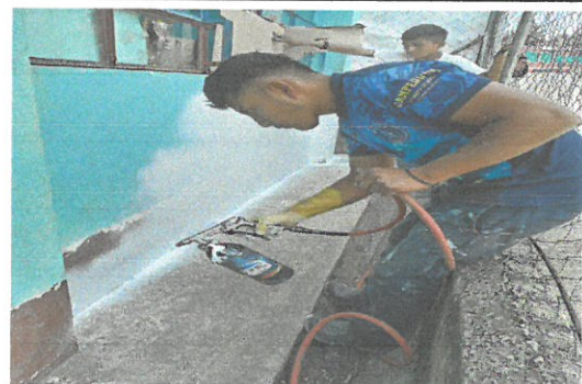
Vista de muros - paredes en proceos a ser remozadas
