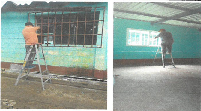
Vista de area de ventanas en proceso de remozamiento
