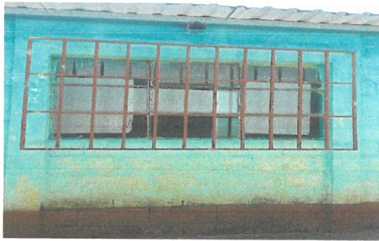
Vista de area de ventanas a remozar.
