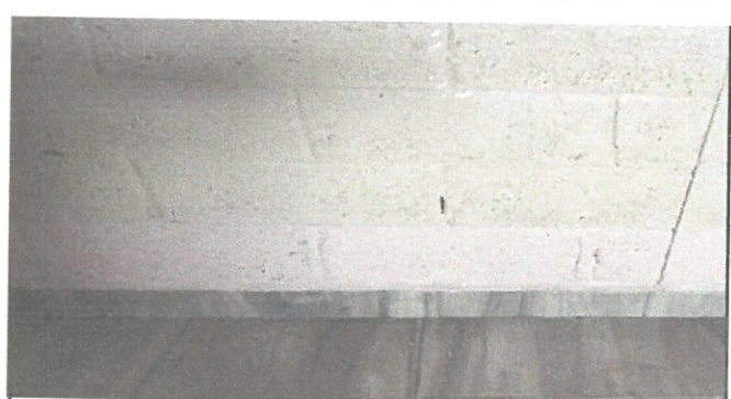
Foto 6: Aplicación de pintura
