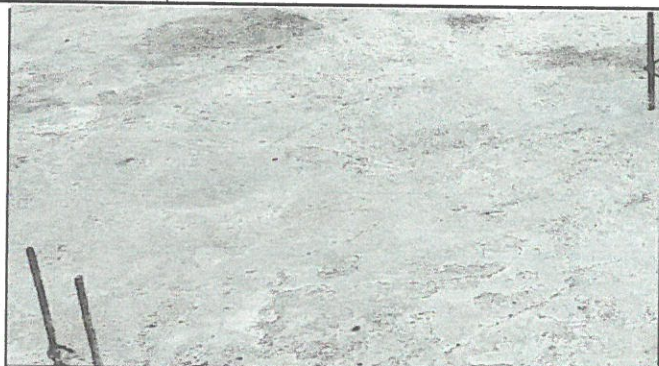
Foto 2: Techo de loza
