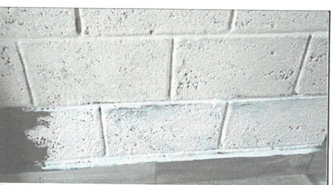
Foto 6: Aplicación de pintura
