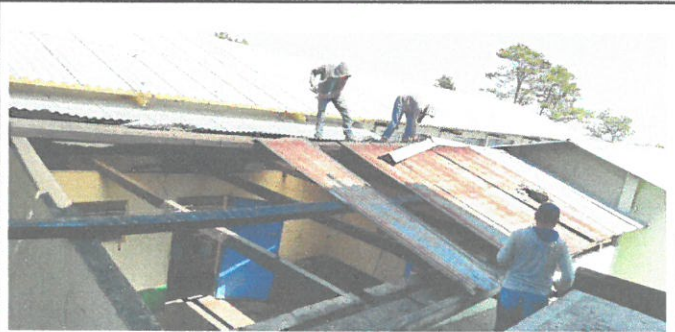
Foto 4: Techo antes de remozar
