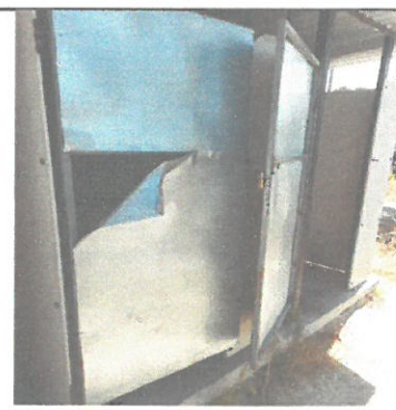
Foto 6: Servicios sanitarios antes de remozamiento
