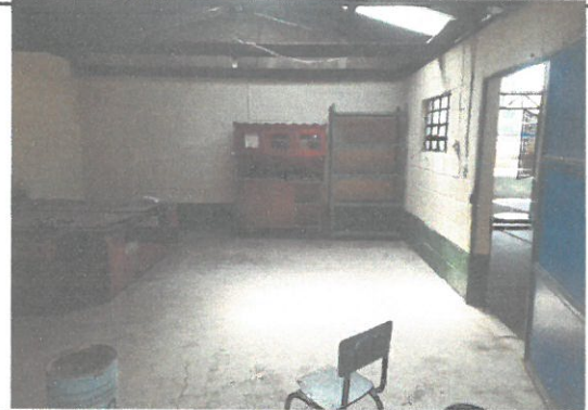
Foto 2: Interior de cocina antes de remozar
