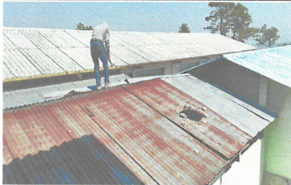
Foto 3: Techo antes de remozar
