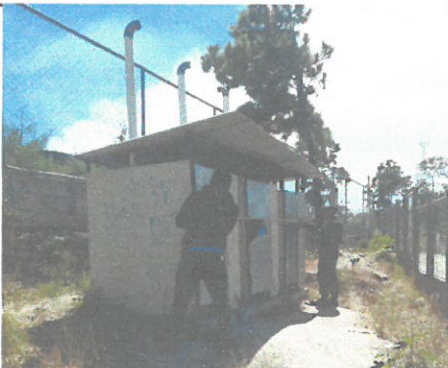
Foto 5: Servicios sanitarios antes de remozamiento
