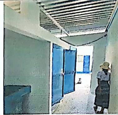
Vista del techo de los baños.
