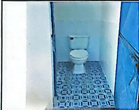
Vista del interior de los baños.
