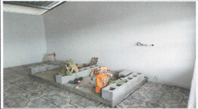
Foto 2: Construcción de nueva plancha
