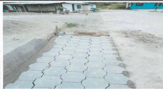
Foto 3: Colocación de adoquín frente a las aulas y cocina
