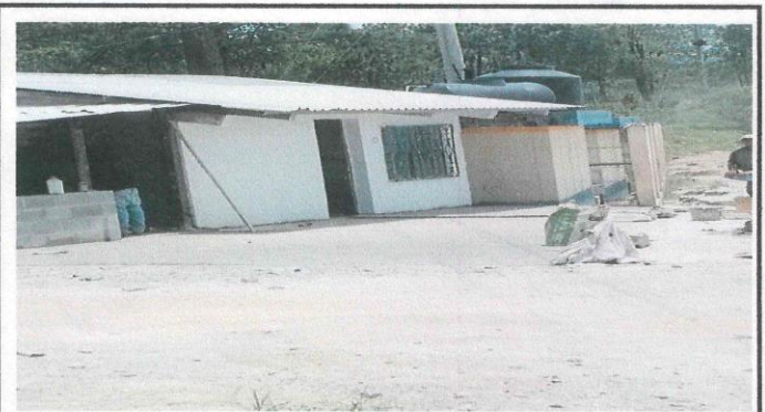
Foto 4: pavimento fuera de la cocina y colocación de adoquín.
