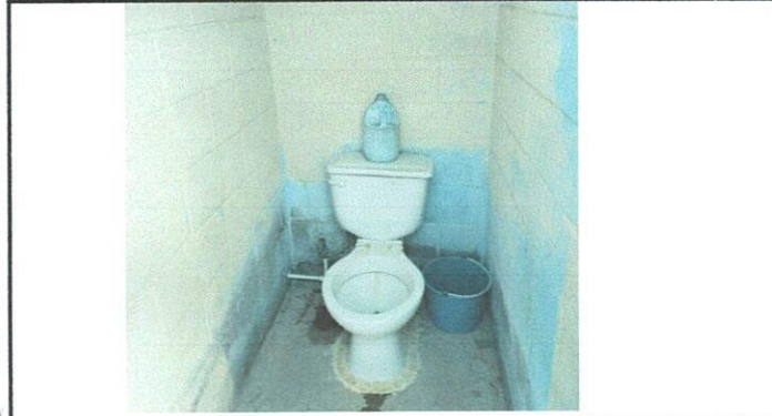
Vista del interior de los baños.
