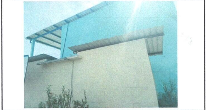
Vista del techo de los baños.
