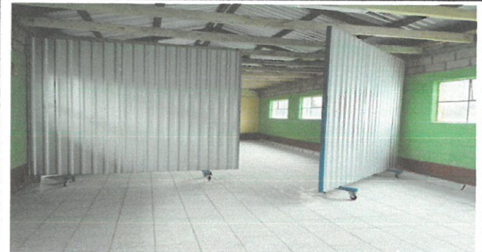
Foto 4: Cambio del interior de los ambientes a una división con rodos giratorios.
