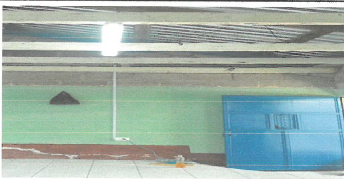
Foto 5: Cambio del sistema eléctrico dentro del ambiente y puertas.
