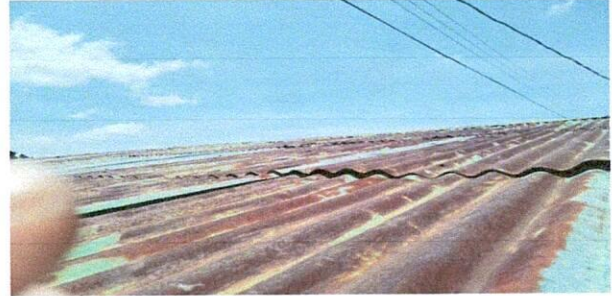
FOTO 2: TECHO DE 2 AULAS (MODULO 2)
