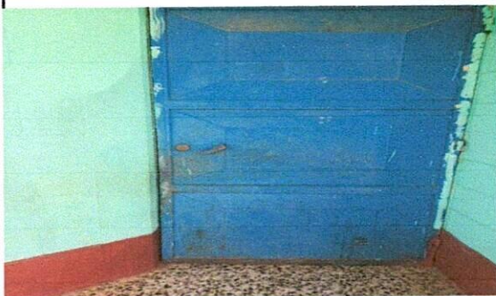
FOTO 3 CAMBIO DE CHAPA Y REPARACION DE 2 PUERTAS
