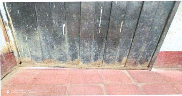
FOTO 5: CAMBIO DE PUERTAS DE 3 AULAS
