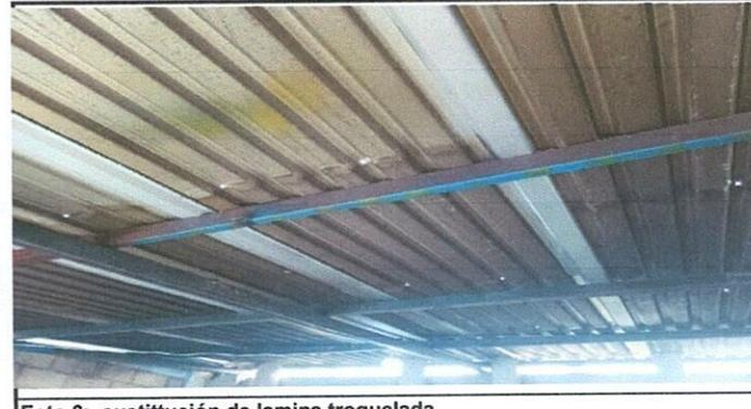
Foto 6: sustittución de lamina troquelada
