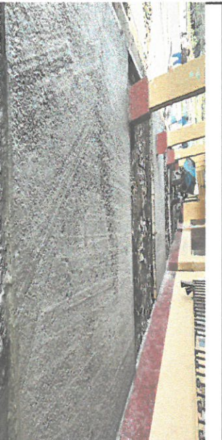
Foto 5. Reparación de plancha de concreto, en corredor del establecimiento, módulo 1.
