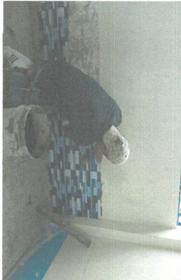
Foto1: colocación de Zócalos
