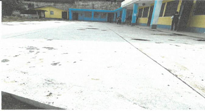
Foto1: Colocacion de pavimento en el patio.
