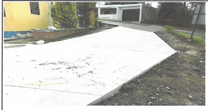
Foto 2: Colocacion de pavimento en el patio.
