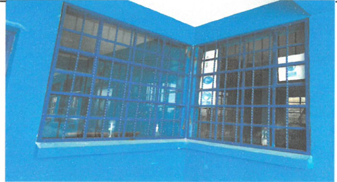
Foto 4: Instalacion de balcones en ventanas.
