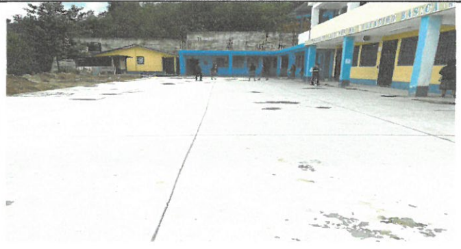
Foto 3: Colocacion de pavimento en el patio.
