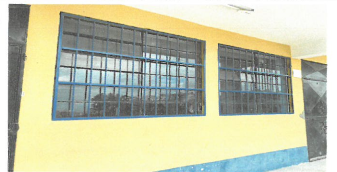
Foto 5: Instalacion de balcones en ventanas.
