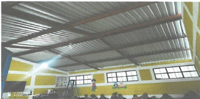
Foto1: sustitución de techado de aula con doble traslape, troquelada.
