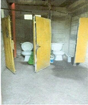
Cambio de baños, pared divisoria y puertas.
