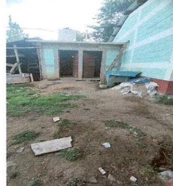
Colocación de piso de concreto en patio
