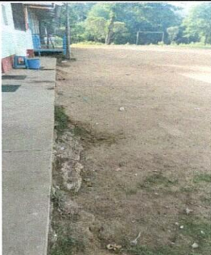
Colocación de piso de concreto en patio
