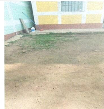
Colocación de piso de concreto en patio.
