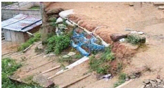
Foto 3: vista de donde se llevara a cabo levantado de blokc
