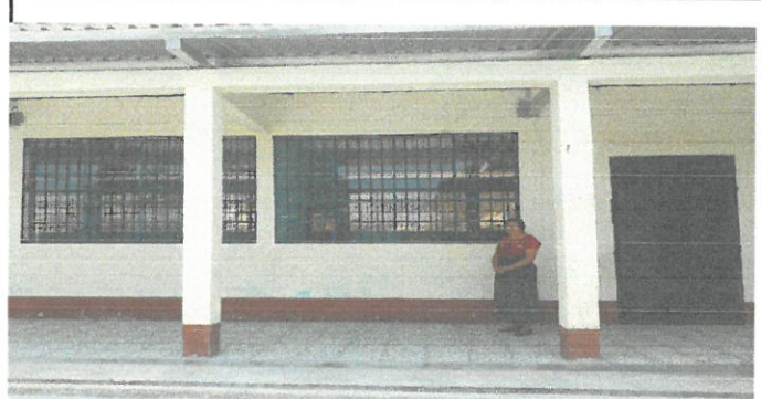
Foto 2: Balcones de ventana
