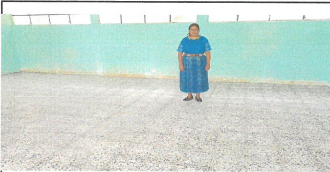
Foto 3: Cambio de piso en mal estado
