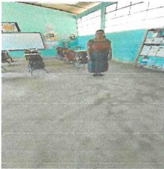
Foto 3: cambio de piso en mal estado
