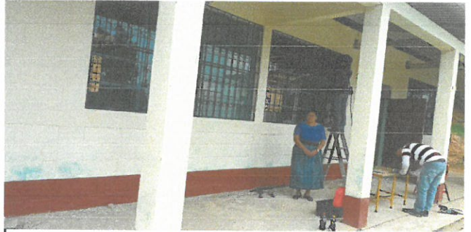
Foto 2: Balcones de ventana
