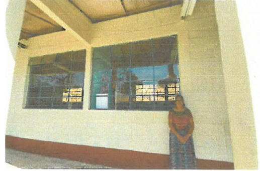
Foto 2: Balcones en ventanas
