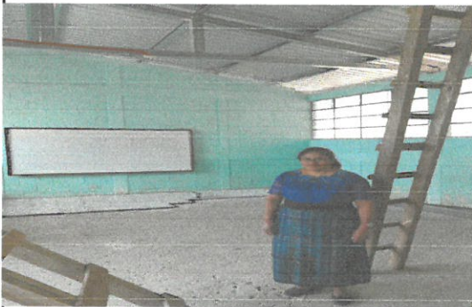
Foto 3: Cambio de piso en mal estado
