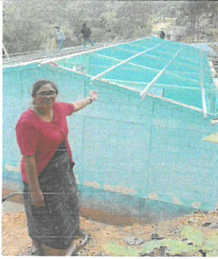
Foto 1: Lámina en mal estado
