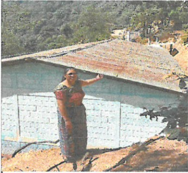
Foto 1: Cambio de láminas en mal estado
