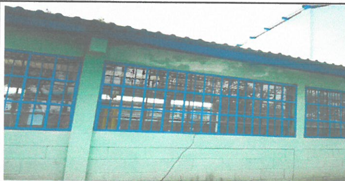
Foto 5: Vista a la cubierta de balcones colocados.
