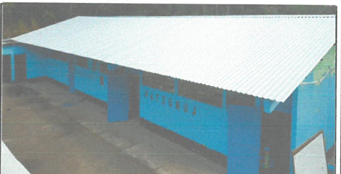
Foto 6: vista ala cubierta de cambio de techo.
