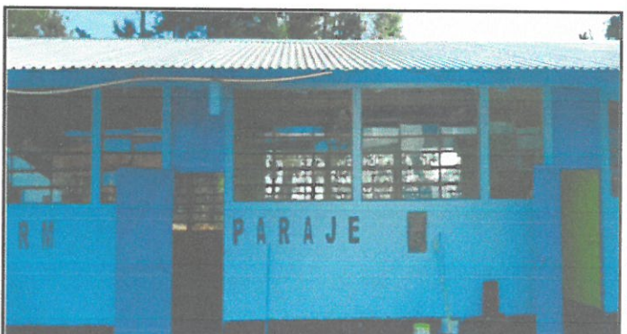
Foto 4: Vista a la cubierta de de cambios de vidrios.
