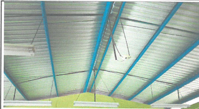
Foto1: vista a la cubierta de costaneras ya pintadas.
