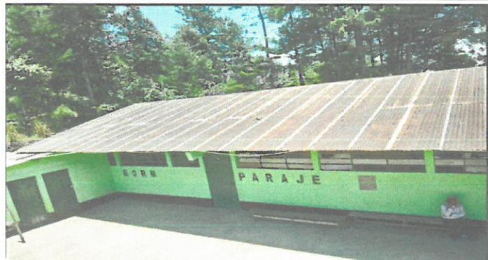
Foto 1: Vista de la cubierta de techo, estas aulas se remozaran con lijado, pintado de costaneras y cambio de techo.
