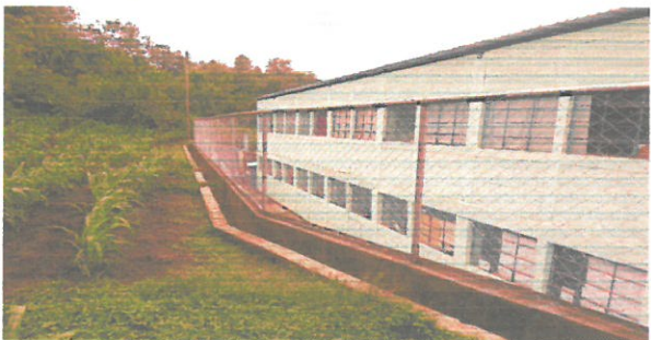
Foto 6: Vista lateral del cerco perimetral.
