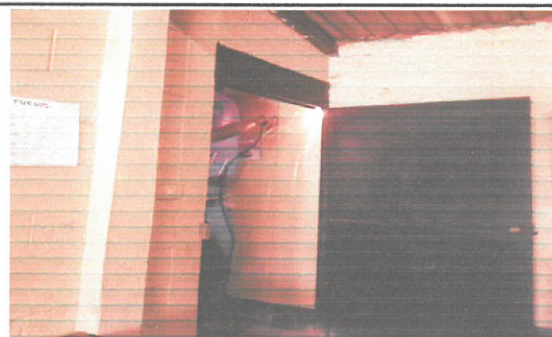
Foto 6: Vista de reajuste e instalacion de la puerta.
