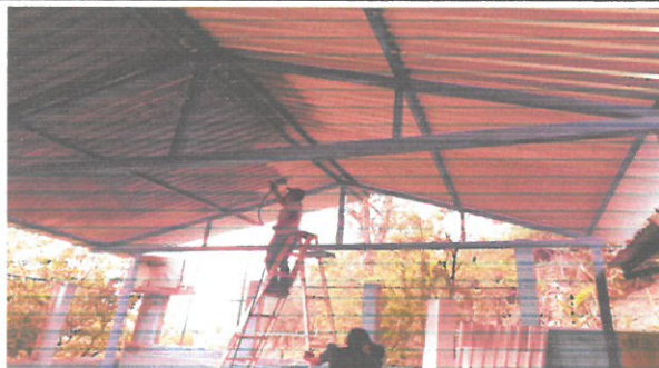
Foto 4: Vista frontal pintando las láminas.
