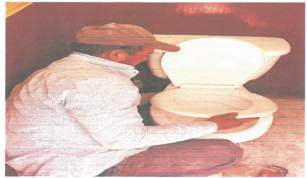
Foto 2: Vista frontal de la colocación de la taza
