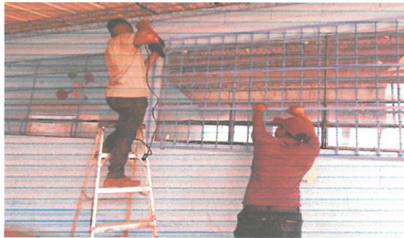
Foto 3: Vista frontal de la instalacion de balcones.
