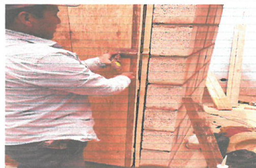
Foto 6: Vista colocación puerta pozo ciego.
