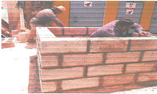
Foto 5: Vista reconstrucción pozo ciego
