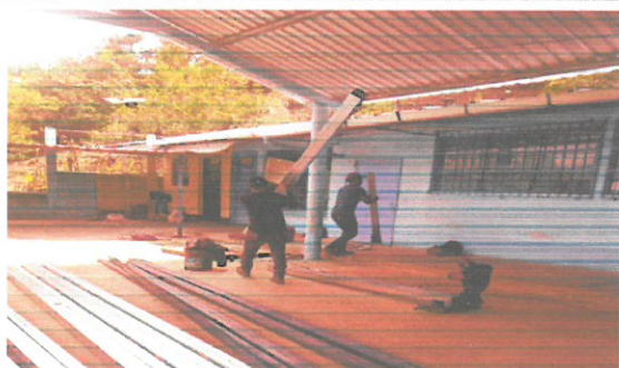
Foto 3: Vista frontal colocación de estructuras metálicas.
