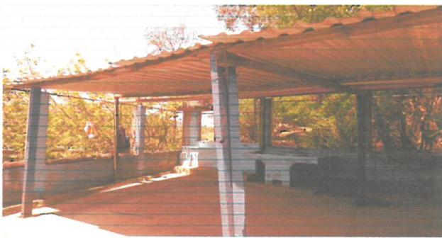
Foto 1: Vista frontal de la estructura de madera por estructura de metal y lámina troquelada.
