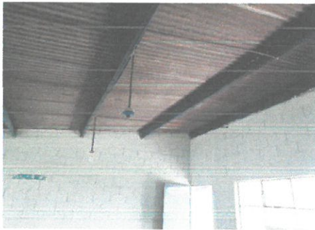
mejoras del instalado eléctrico
