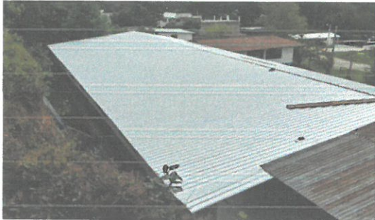
cambio de techo
