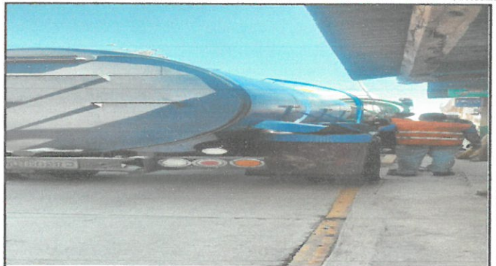
Foto 2: Realizando la limpieza de foza séptica.
