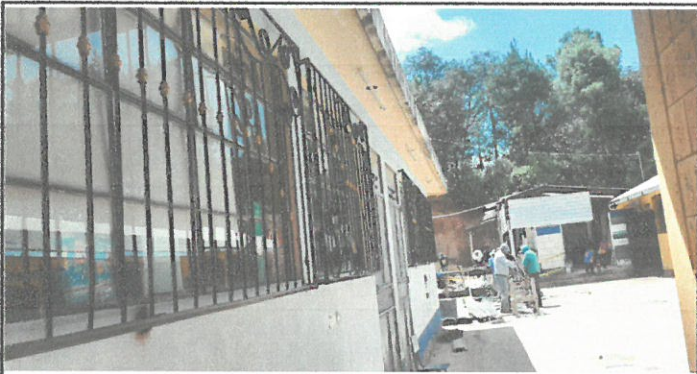
Foto 3: Cambio de tubería de drenaje.
