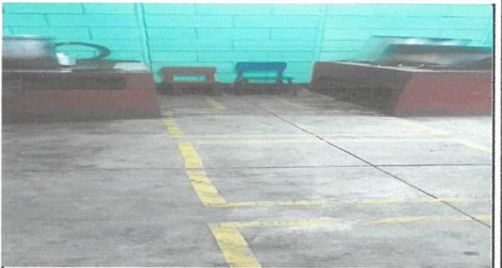
Foto 4: Cambio de piso.
