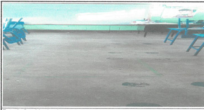
Foto 5: Cambio de piso.
