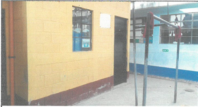
Foto 3: Limpieza de foza séptica.
