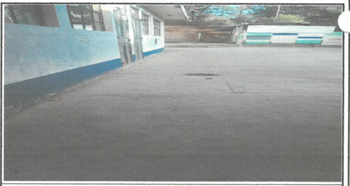
Foto 6: Cambio de tubería de drenaje.
