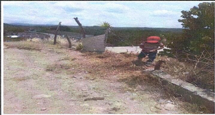
Foto 4: Se ha colocado laminas por el riesgo de peñascos.
