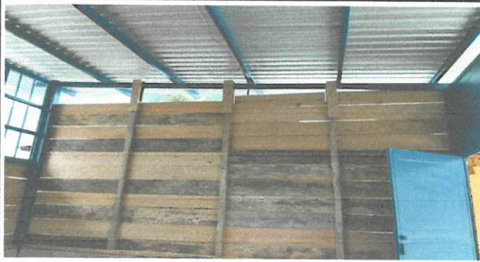
Foto 1: Techo con lámina galvanizada y estructura de metal, pared de madera y puerta de metal.
