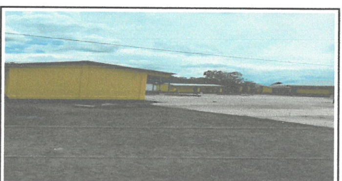
Foto 6: Terminación de pintada de toda la escuela
