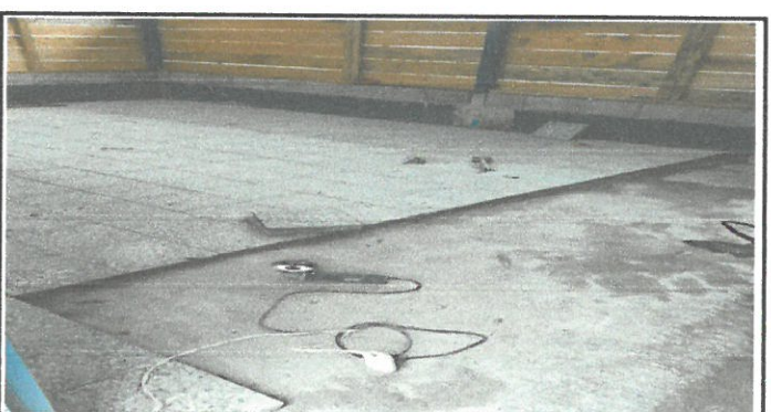
Foto 6. Colocación de piso en el aula.
