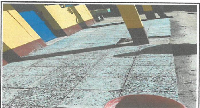
Foto 4: Colocación de piso en pasillo.
