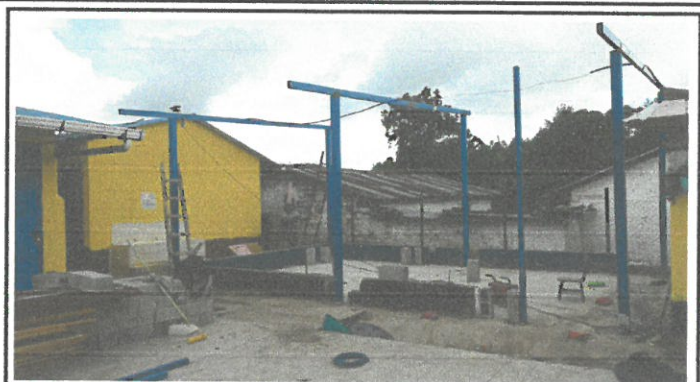
Foto 2: Paredes con estructura de metal
