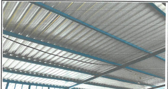
Foto 2: Techo con lámina galvanizada y estructura de metal.
