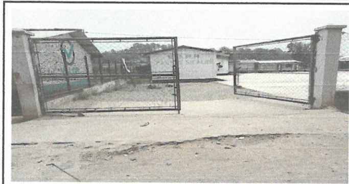
Foto 1: Aplicación de pintura en la puerta principal
