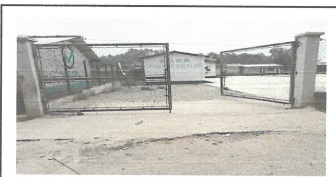
Foto 5: Aplicación de pintura en toda la escuela
