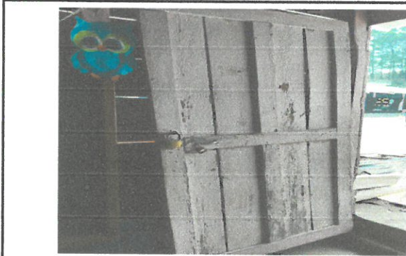
Foto 3: Sustitución de puerta de madetra por puerta de metal.
